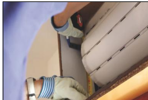
Rilevare le misure del vano laterale
