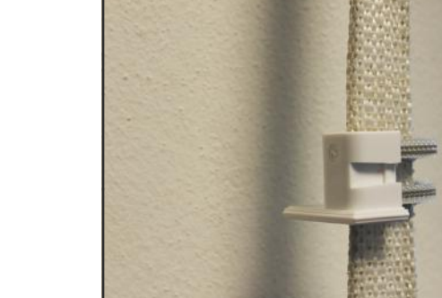
Dopo aver separato i due pezzi di cui è composto il passacinghia, infilarne uno facendo attenzione alla posizione delle spazzoline
