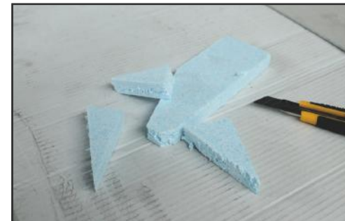
Con gli scarti rimasti formare dei cunei da inserire tra avvolgibile e i profili
