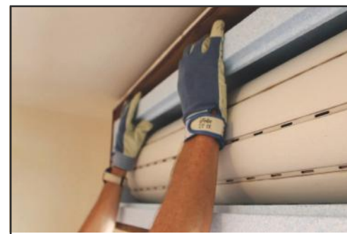
Inserire i profili 3 e 4 provvisoriamente per verificare se sono stati sagomati in modo corretto
