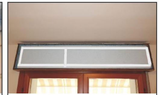
Riposizionare il pannello frontale e sigillare tramite nastro
