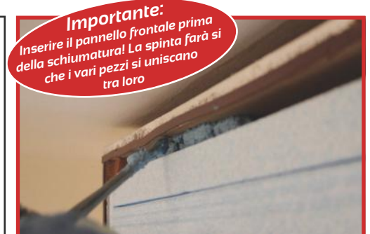
Inserire il pannello frontale incastrandolo dal lato con l'incavo; schiumare lo spazio tra cassonetto e profili 1, 2, 3, 4
