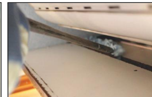
Rimuovere il profilo inferiore (4) e schiumare alla base del cassonetto (preferibilmente a tapparella abbassata)
