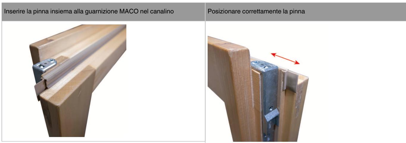
La pinna copre ora la fuga fra il montante centrale della seconda anta e i traversi inferiore e superiore (in figura il dettaglio superiore)
