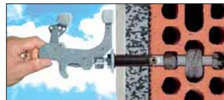
Introdurre il tassello ruotandolo leggermente sia a destra che a sinistra e spingerlo fino alla battuta della testa con la parete e posizionare nel punto esatto.
