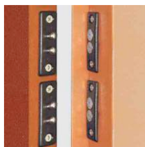
Doppi contatti elettrici tra anta e telaio
