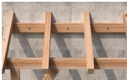
Tettoie in legno.
