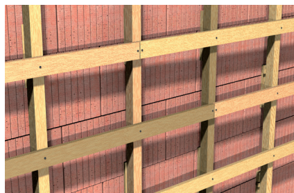
Sottostrutture di facciate
